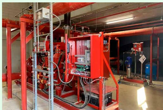
de refroidir la motopompe. Afin d'éviter le gaspillage et que ces eaux deviennent des eaux grises, nous avons pris la décision d'équiper tous nos sites d'un système de recyclage des eaux de refroidissement. Les eaux servant à refroidir la motopompe sont ainsi réinjectées dans la cuve de sprinkler dans le but d'être réutilisées. En moyenne, nous permettons de faire économiser plus de 300 m<sup>3</sup> d'eaux par an à nos futurs utilisateurs.
